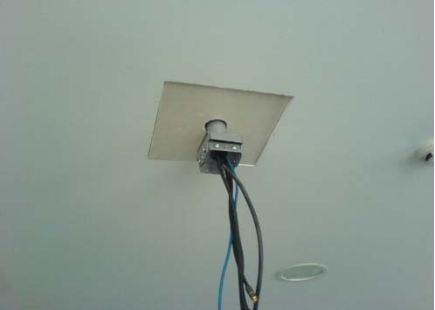
Exemple d'intégration de vidéoprojection avec faux-plafond non-démontable
