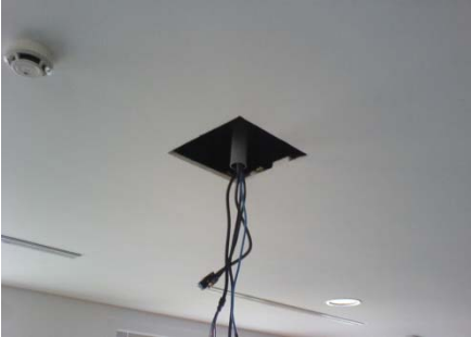
Exemple d'intégration de vidéoprojection avec faux-plafond non-démontable
